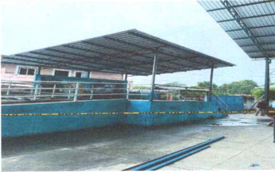
Foto1: CONTRUCCIÓN DE GALERA DEL ESENARIO
