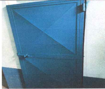
Foto 2: REPARACIÓN DE PUERTAS DE BAÑO
