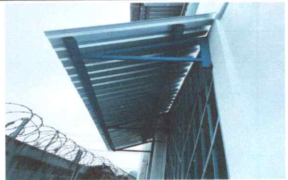
CONSTRUCCIÓN DE ALERO PARA LAS AULAS
