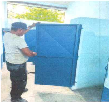
Foto 4: REPARACIÓN DE PUERTAS DE AULAS
