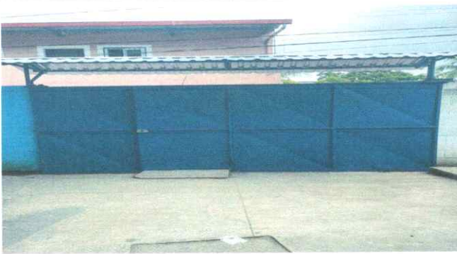
Foto 3: REPARACIÓN DEL PORTÓN PRINCIPAL DE LA ESCUELA
