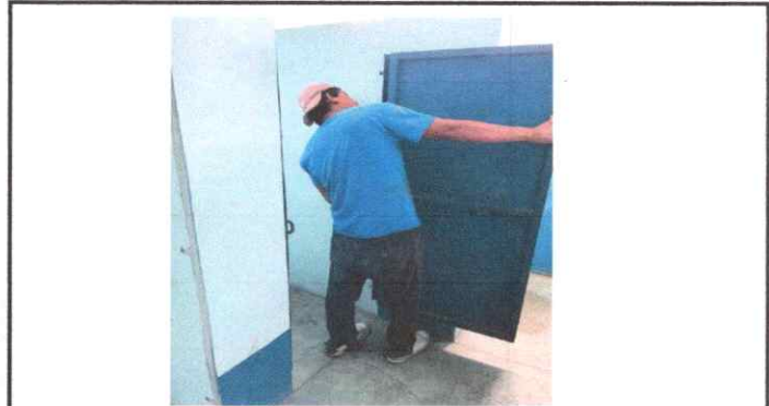
Foto 2: REPARACIÓN DE PUERTAS DE LOS BAÑOS
