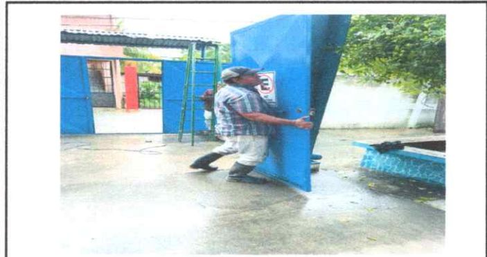
Foto 3: REPARACIÓN DEL PORTÓN PRINCIPAL DE LA ESCUELA
