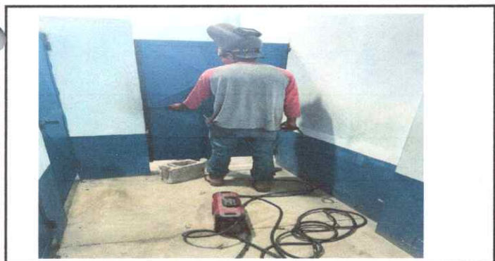
Foto 5: REPARACIÓN DE PUERTAS DE BAÑO
