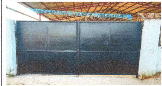
Mantenimiento a porton de metal
