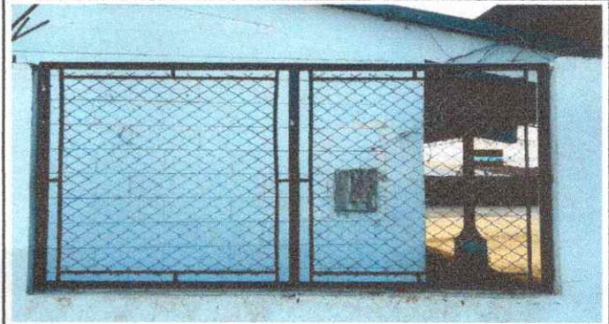
Reparacion de tubo hg y malla galvanizada
