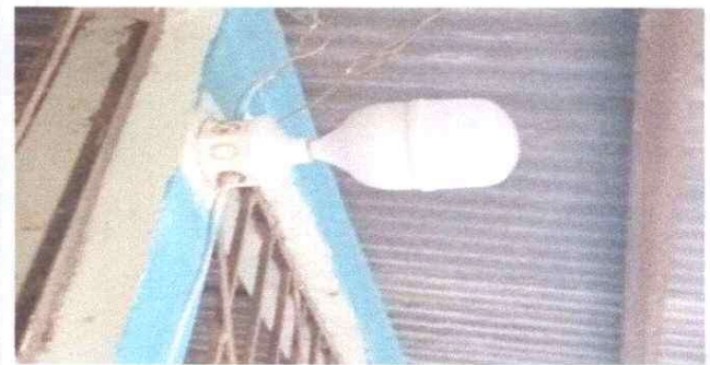
Foto 6: SUSTITUCIÓN DE PLAFONERAS
