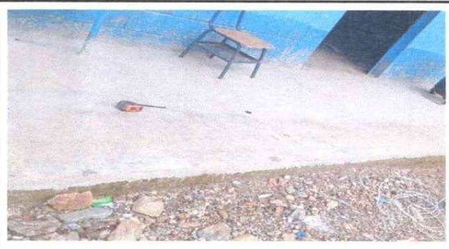
Foto 2: SUSTITUCIÓN DE TORTA DE CONCRETO
