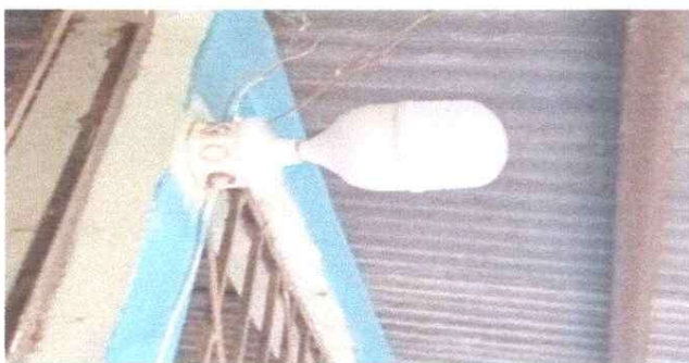
Foto 5: SUSTITUCIÓN DE LAMPARAS TIPO LED
