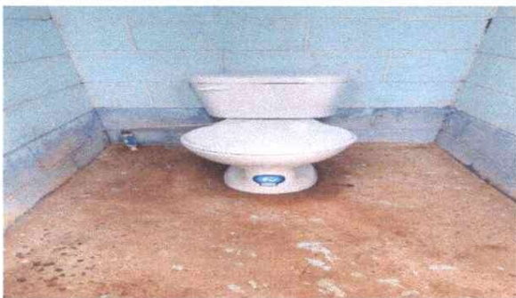
Foto 3: SUSTITUCIÓN DE INODOROS
