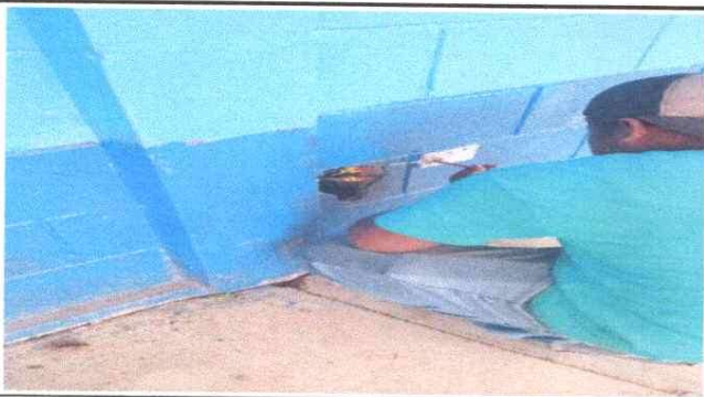
Foto 5: SUSTITUCION DE TOMACORREINTES
