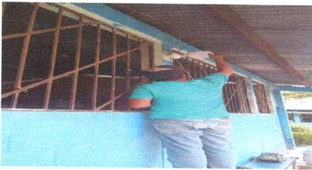
Foto 3: SUSTITUCION DE LAMPARA POR NUEVAS
