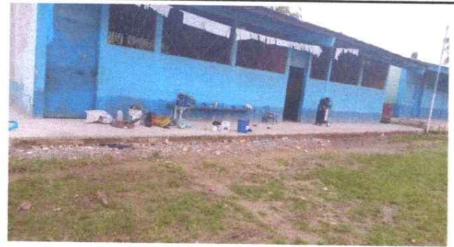
Foto 2: SUSTITUCIÓN DE TORTA DE CONCRETO
