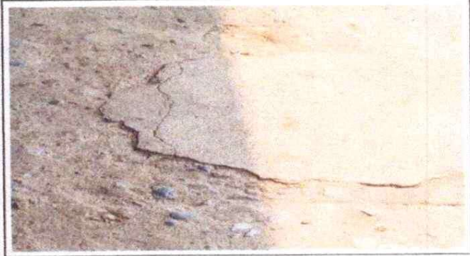
Foto 2: SUSTITUCIÓN DE TORTA DE CONCRETO
