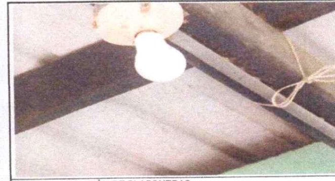
Foto 6: SUSTITUCIÓN DE PLAFONERAS
