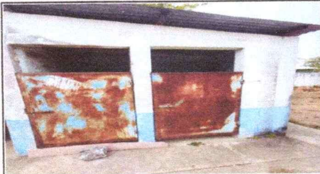
Foto 1: SUSTITUCIÓN DE PUERTAS
