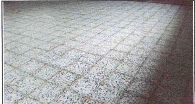
Foto 2: REPARACIÓN DE PISO DE GRANITO EN COCINA
