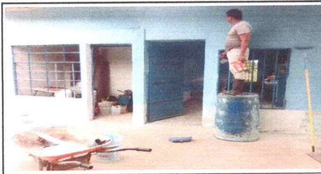
Foto 5: PINTURA EN MUROS EXTERIORES
