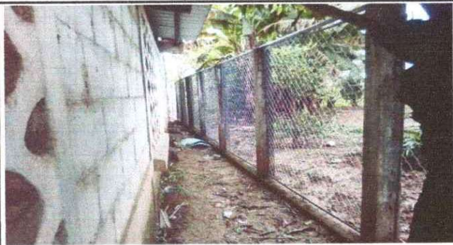
Foto 1: REPARACIÓN DE MURO PERIMETRAL DE BLOCK
