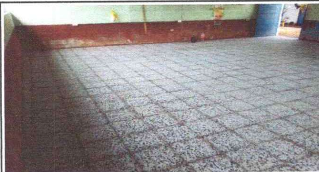
Foto 3: REPARACIÓN DE PISO DE GRANITO EN AULA 1
