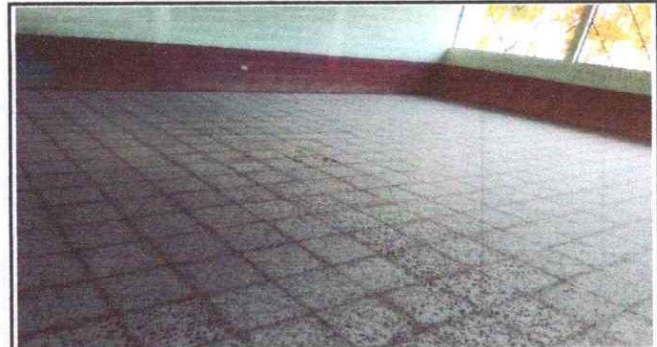
Foto 4: REPARACIÓN DE PISO DE GRANITO EN AULA 2
