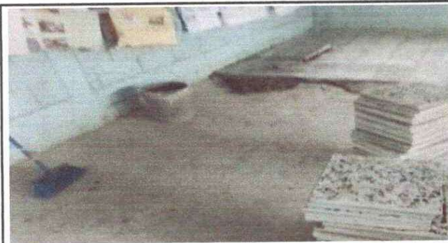
Foto 3: REPARACIÓN DE PISO DE GRANITO EN AULA 1
