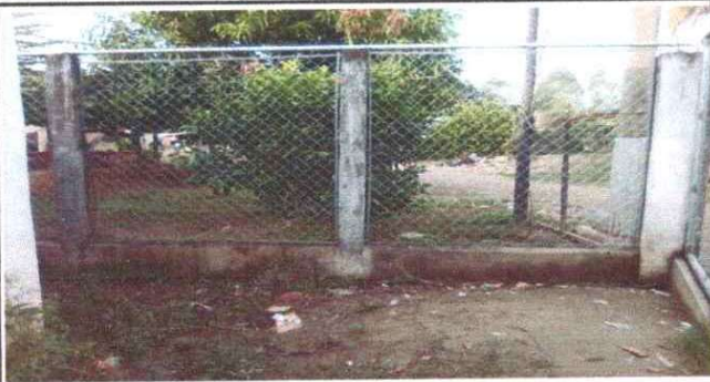
Foto 1: REPARACIÓN DE MURO PERIMETRAL DE BLOCK
