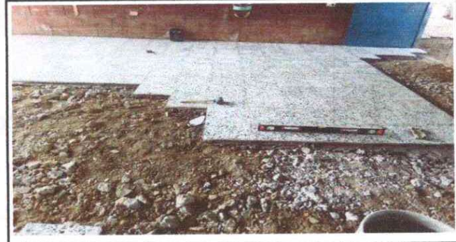
Foto 4: REPARACIÓN DE PISO DE GRANITO EN AULA 2
