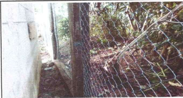
Foto 1: REPARACIÓN DE MURO PERIMETRAL DE BLOCK
