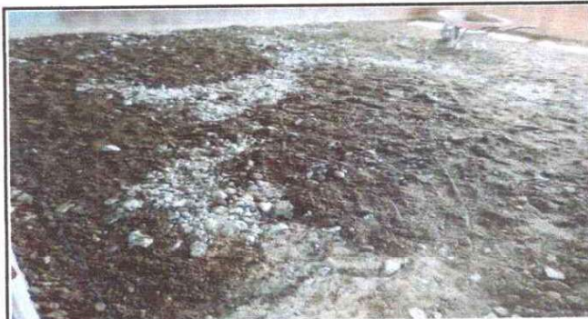
Foto 3: REPARACIÓN DE PISO DE GRANITO EN AULA 1
