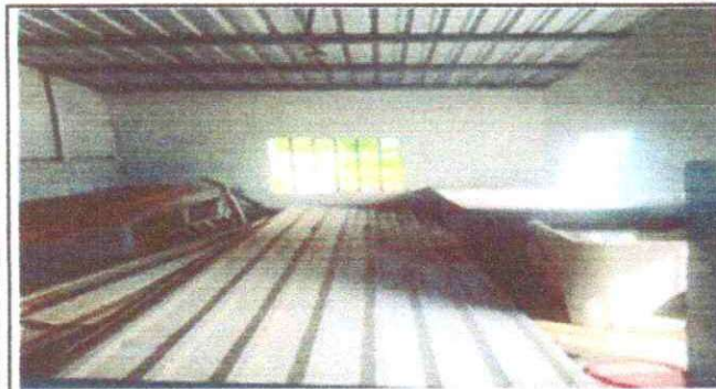
Foto 3: MANTENIMIENTO DE ESTRUCTURA DE SOPORTE DE METAL
