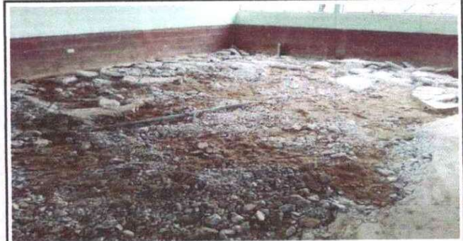
Foto 4: REPARACIÓN DE PISO DE GRANITO EN AULA 2
