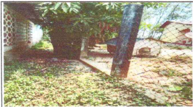
Foto1: REPARACIÓN DE MURO PERIMETRAL DE BLOCK
