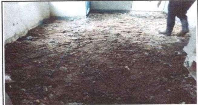
Foto 2: REPARACIÓN DE PISO DE GRANITO EN COCINA
