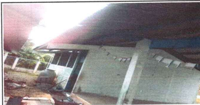
Foto 5: PINTURA EN MUROS EXTERIORES
