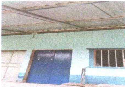
FOTO 13: sustitucion de puestas
