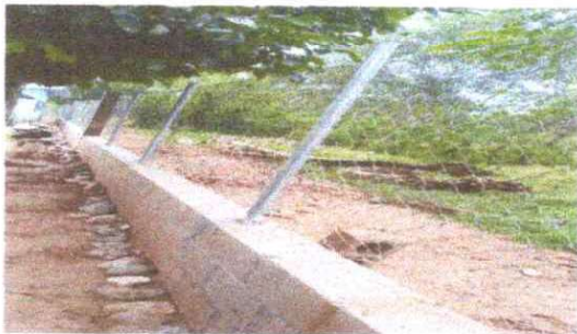
Foto 15: Reparación de muro de contención
