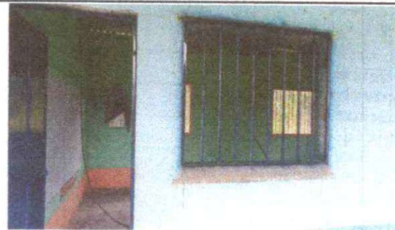
FOTO 14: sustitucion de balcones de metal
