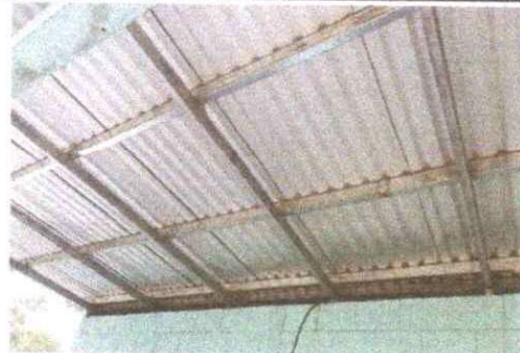
FOTO 12: sustitucion d estructura de soporte de madera por metal
