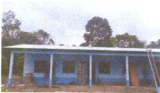
FOTO 11: Sustitución de lamina troquelada por aluzinc calibre 26
