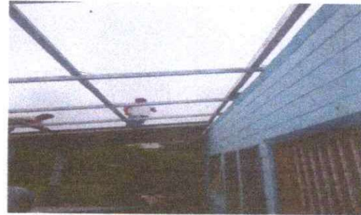
FOTO 7: sustitucion d estructura de soporte de madera por metal
