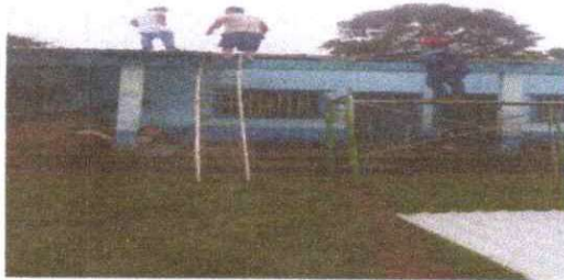
FOTO 6: Sustitución de lamina troquelada por aluzinc calibre 26
