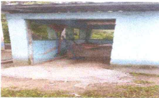
FOTO 8: sustitucion de puertas
