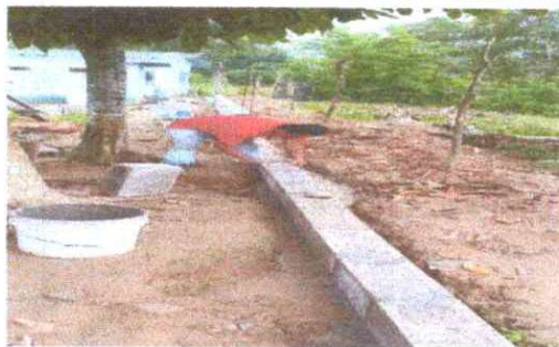
Foto 10: Reparación de muro de contención
