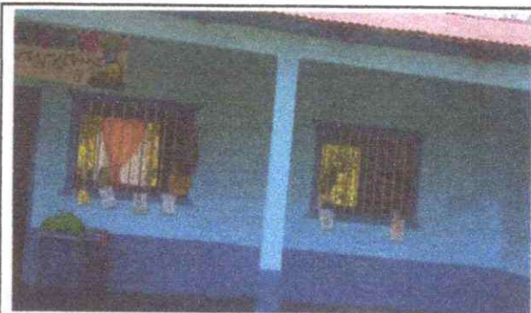
FOTO 4: sustitucion de balcones de metal
