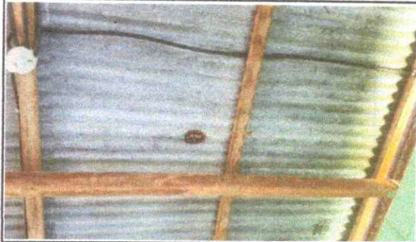
FOTO 2: sustitucion d estructura de soporte de madera por metal
