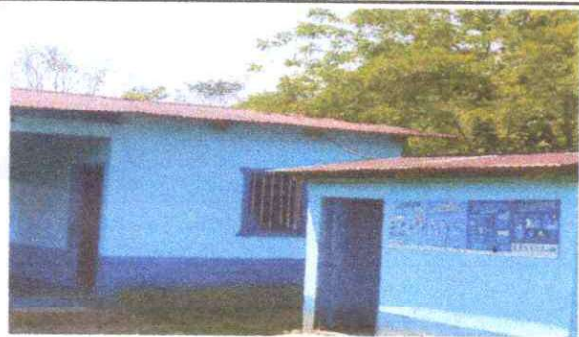
FOTO 3: sustitucion de puertas
