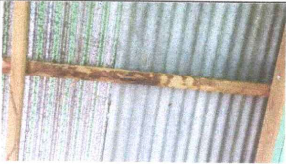
FOTO 1: Sustitución de lamina troquelada por aluzinc calibre 26
