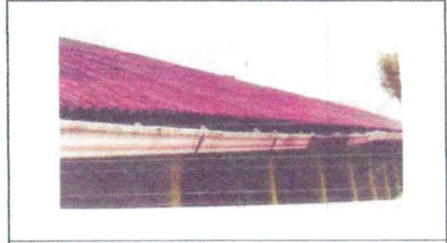
Foto 4: Sustrucción de canal de pvc
