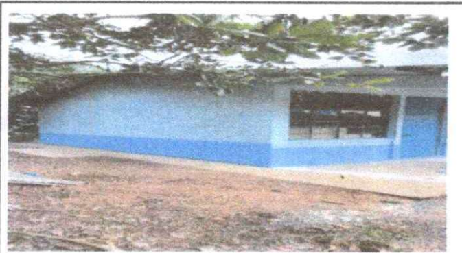
Foto 9 Pintura de muros exterior e interior
