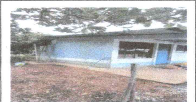
Foto 6 Pintura de muros exterior e interior
