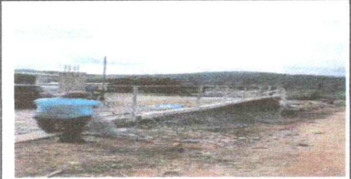
Foto 4 Reparacion de muro perimetral de block con tubo hg, malla galvanizada, solera y columnas .
