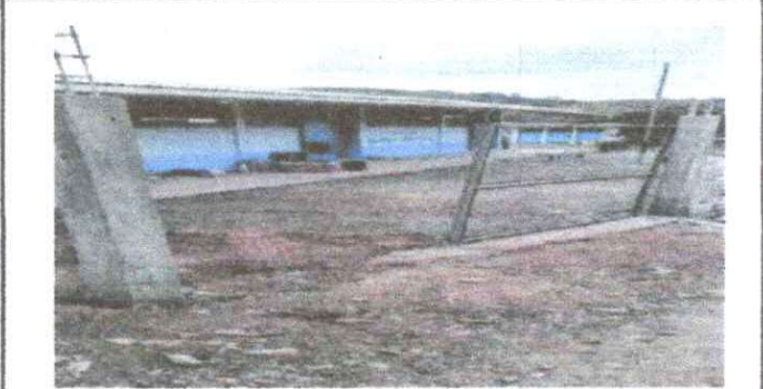
Foto 5 Sustitucion de porton de madera por tubo hg y malla galvanizada
