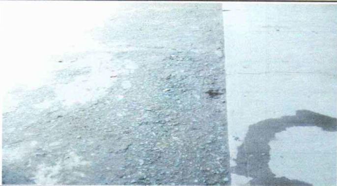
Foto 7: SUSTITUCIÓN DE PISO CERAMICO ANTILISANTE, EN AREA DE BAÑO
