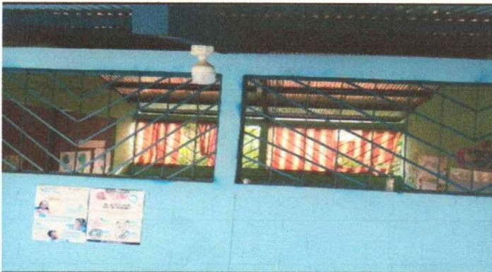
Foto 3: MANTENIMIENTO DE BALCONES DE METAL
