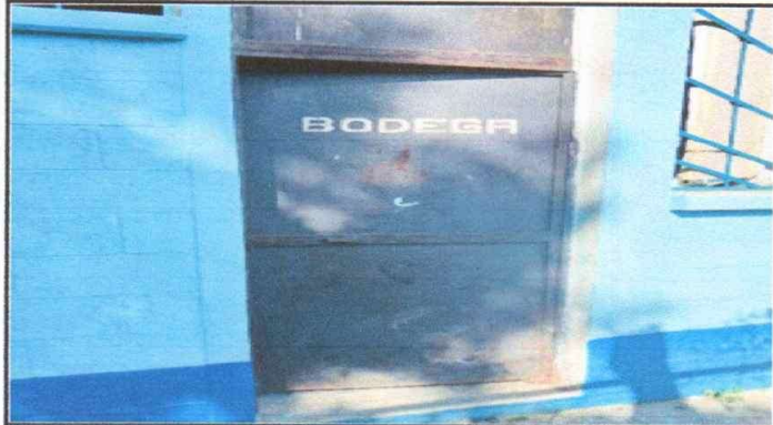
Foto 1: SUSTITUCIÓN DE PUERTA DE BODEGA
