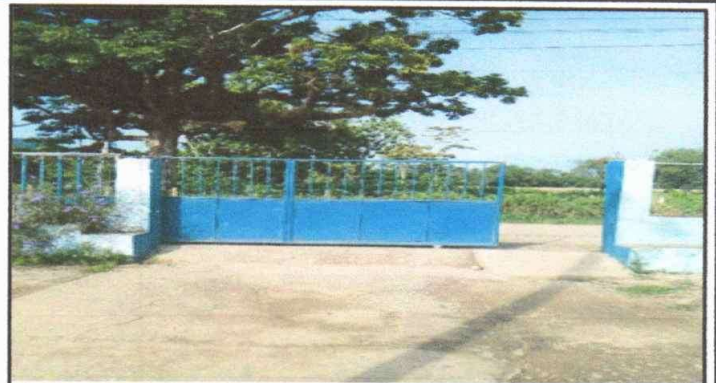
Foto 2: SUSTITUCION DE PORTÓN DE METAL
