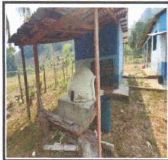
SUSTITUCIÓN DE LÁMINA POR LAMINA TROQUELADA EN COCINA
