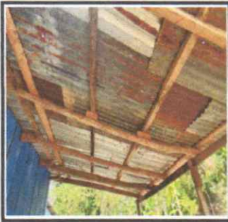
SUSTITUCIÓN DE LÁMINA POR LAMINA TROQUELADA EN COCINA
