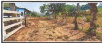
SUSTITUCIÓN DE PORTÓN ENTRADA PRINCIPAL
