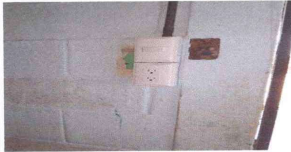
Foto 16: Sustrucción de Interruptores Dobles
