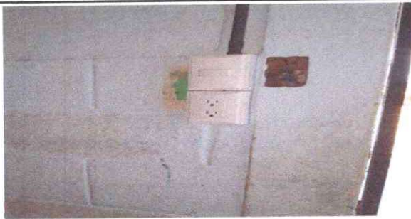
Foto 17: Sustrucción de tomacorrientes Dobles
