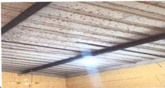
Foto 15: Sustrucción de plafoneras
