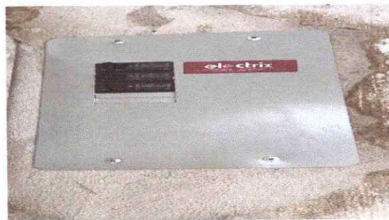
Foto 18: Sustrucción de tablero de flipones
