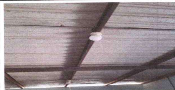
Foto 20: Sustrucción de ducto electrico mas accesorio
