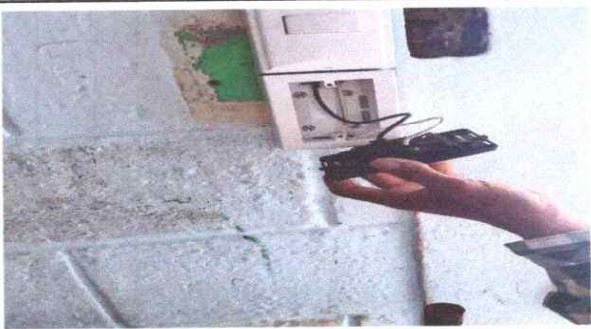
Foto 10: Sustrucción de tomacorrientes Dobles
