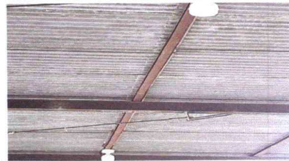
Foto 13: Sustrucción de ducto electrico mas accesorio
