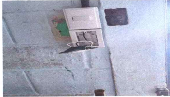
Foto 9: Sustrucción de Interruptores Dobles
