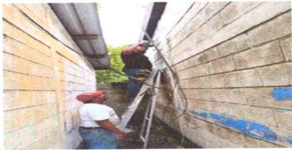
Foto 12: Reparación de cableado electrico
