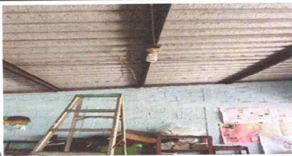
Foto 8: Sustrucción de plafoneras
