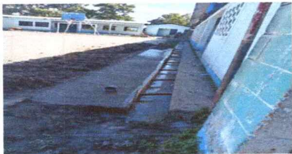
Foto 14: Reparación de cuneta de concreto
