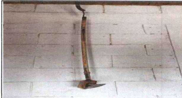
Foto 2: Sustrucción de Interruptores Dobles
