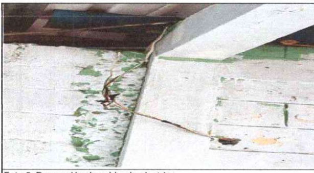
Foto 5: Reparación de cableado electrico
