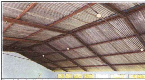
Foto 6: Sustrucción de ducto electrico mas accesorio
