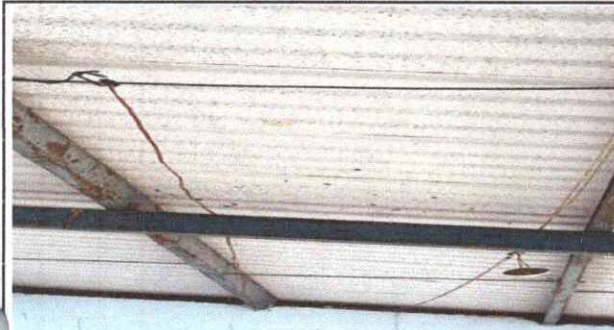
Foto 1: Sustrucción de plafoneras
