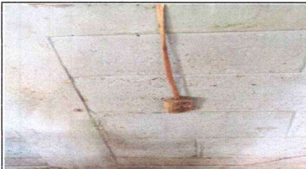
Foto 3: Sustrucción de tomacorrientes Dobles
