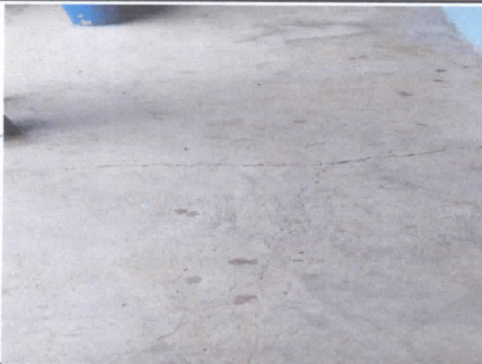
FOTO 5. sustitución de piso de torta de concreto
