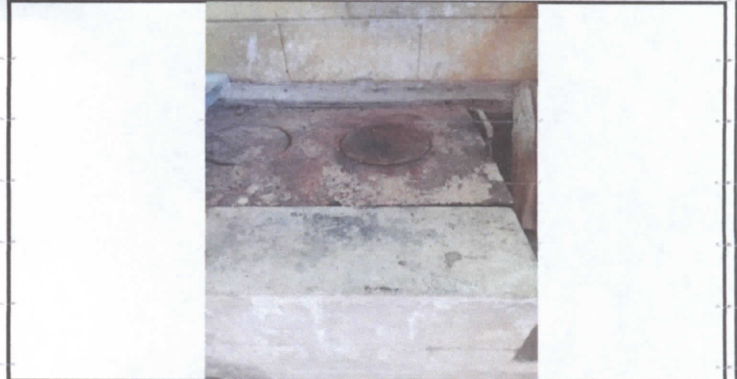
FOTO 14. Sustitución de plancha de metal de 3 hornillas
