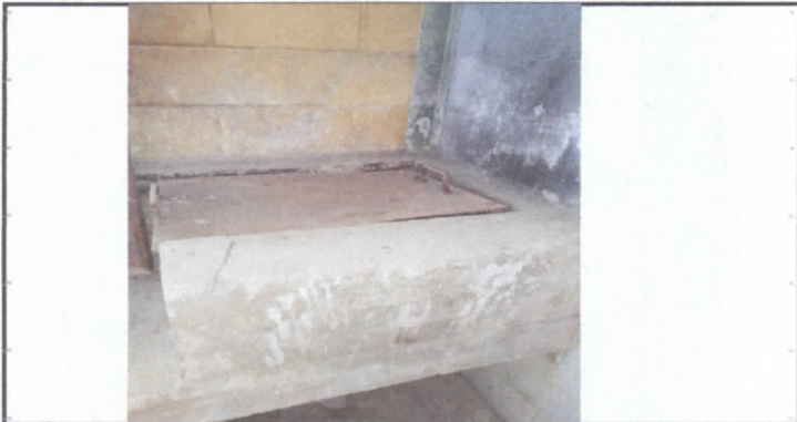
FOTO 15. Instalación de azulejo en estufa rural.
