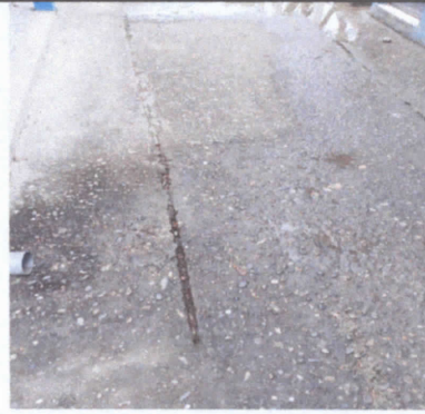
FOTO 8. Reparación de planchas de concreto de patio.
