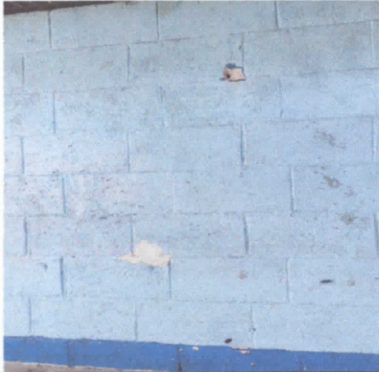
FOTO 7. Pintura en muros exteriores e interiores
