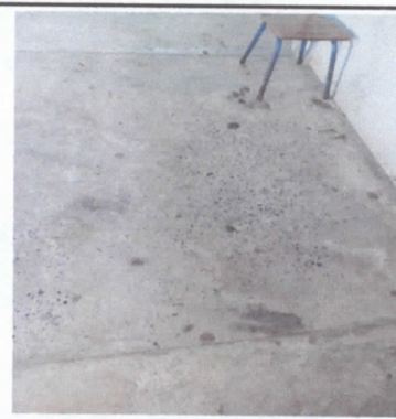
FOTO 4. Sustitución de piso de torta de concreto
