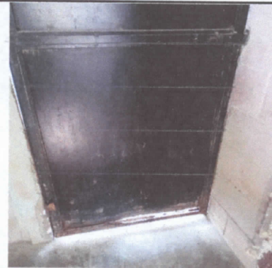
FOTO 2. Sustitución de puerta
