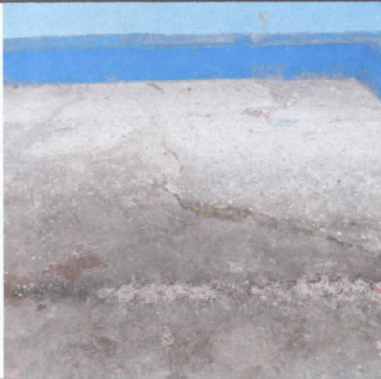
FOTO 9. Reparación de planchas de concreto de patio.
