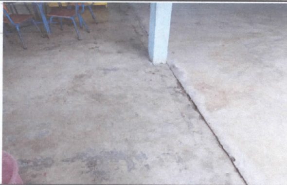
FOTO 3. Sustitución de piso de torta de concreto
