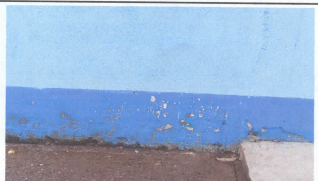
FOTO 6. Pintura en muros externos e interiores
