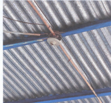
FOTO 12. Reparación de cableado eléctrico. Sustitución de ducto eléctrico mas accesorios.
