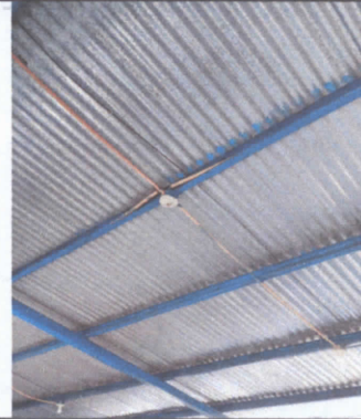
FOTO 10. Sustitución de focos ahorradores
