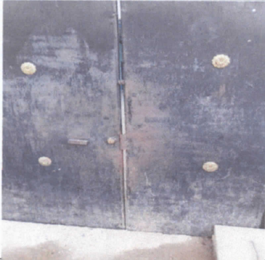
FOTO 1. Mantenimiento a estructura (lijado, cepillado y aplicación de pintura). Sustitución de chapa.
