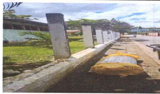
Foto 2: RAPARACIÓN DE TUBO HG Y MALLA GALVANIZADA
