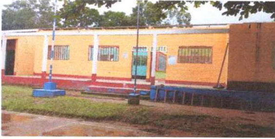
Foto1: SUSTITUCIÓN DE ESTRUCTURA DE SOPORTE DE MADERA POR METAL
