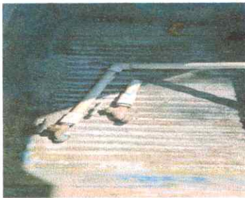
Foto 5: Reparación de Red de agua potable
