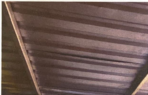
Foto 9: INSTALACION DE LAMINA
