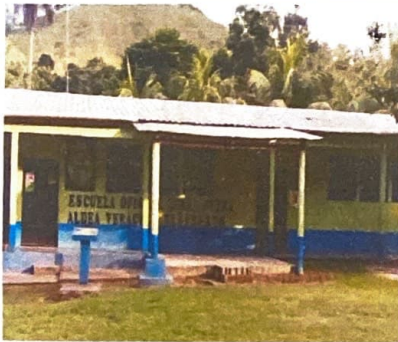
Foto7: ESTRUCTURA DE BASES DE CONCRETO
