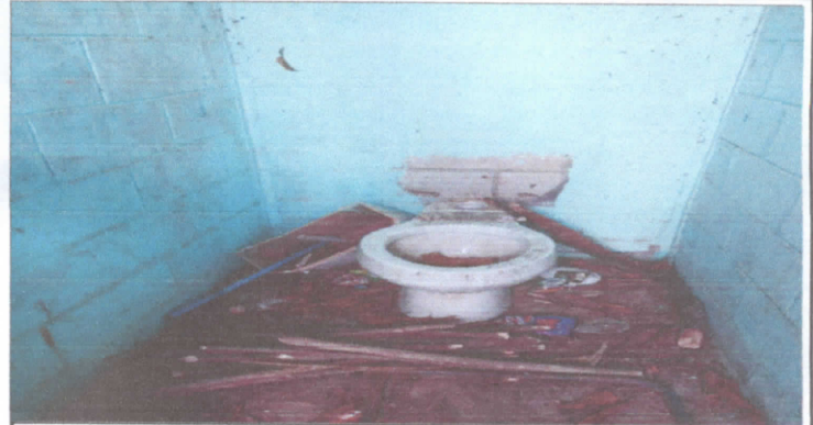
Sustitución de accesorios inodoros contra llave, tubo de abasto. Sustitución de tapadera sanitario. Sustitución inodoro
