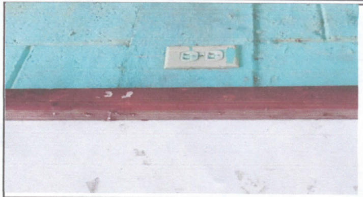
Sustitución de tomacorriente dobles, Sustitución de Flipones
