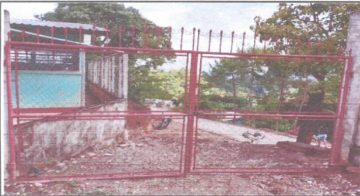
Mantenimiento a portones de metal
