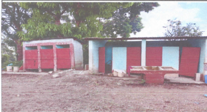
Mantenimiento a estructura, lijado cambio de tubo, cepillado sujecciones de pintura a puertas servicios sanitarios
