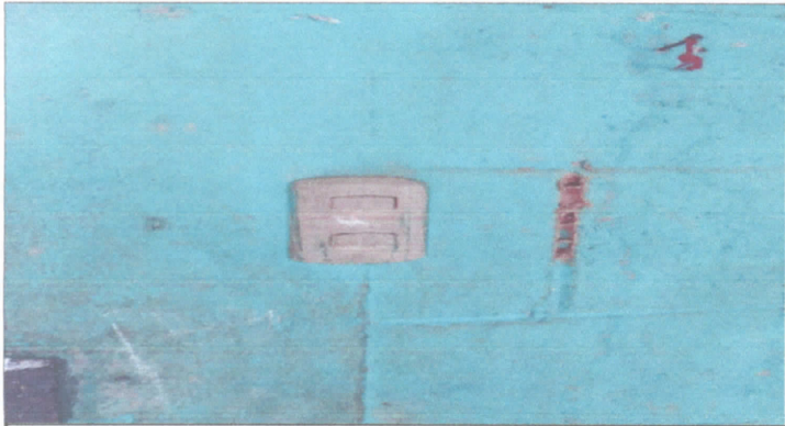
Sustitución Interruptores Simples
