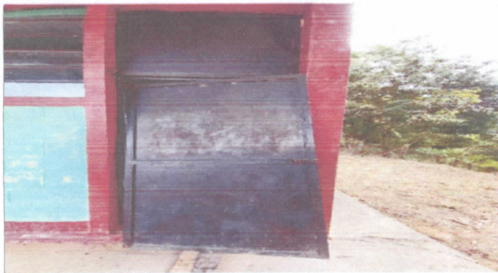
mantenimiento de estructura (lijado de soporte de metal por metal, sustitución de puerta
