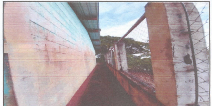
Pintura en muros exteriores e interiores
