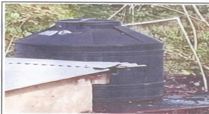
Sustitución de deposito de agua 1000 litros
