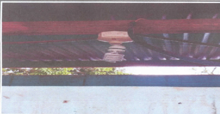
Sustitución de focos ahorradores
