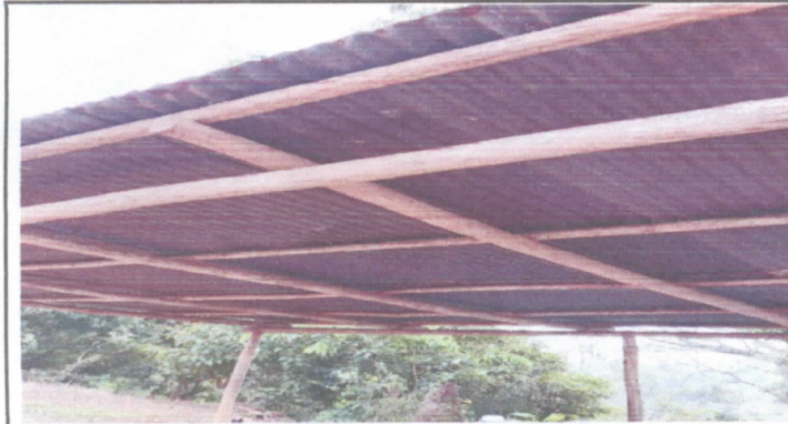
sustitución de lámina, por lamina troquelada aluzine calibre 26
