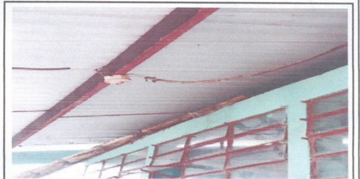
Sustitución de plafonera
