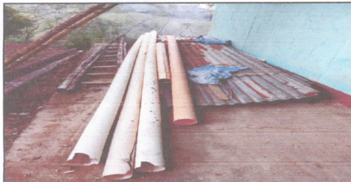
Reparación de bajada de agua pluvial. Tubo PVC "3"
