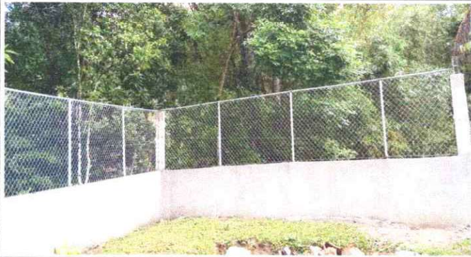
Foto 1: Muro perimetral con malla galvanizada y tubo hg del establecimiento educativo
