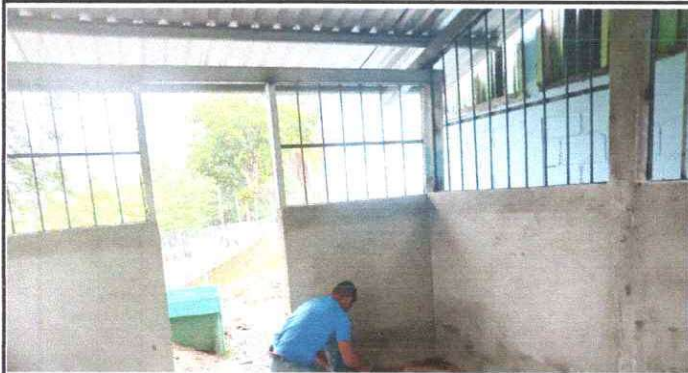
Foto 3: Repello, cernido y alisado en paredes de cocina
