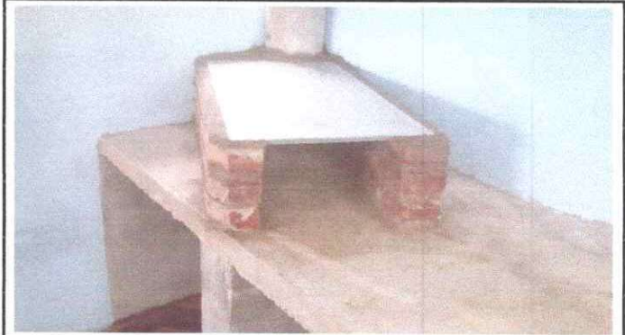
Foto 2: Sustitución y Reparación de estufa rural con chimenea en cocina del establecimiento
