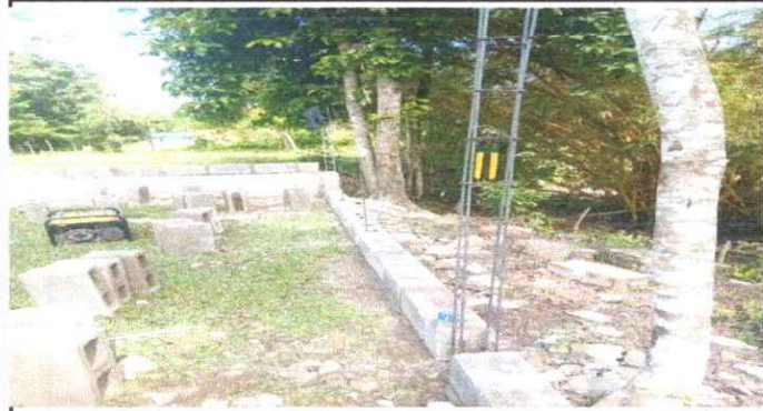
Foto 1: Reparación de muro perimetral de block con tubo hg y malla galvanizada
