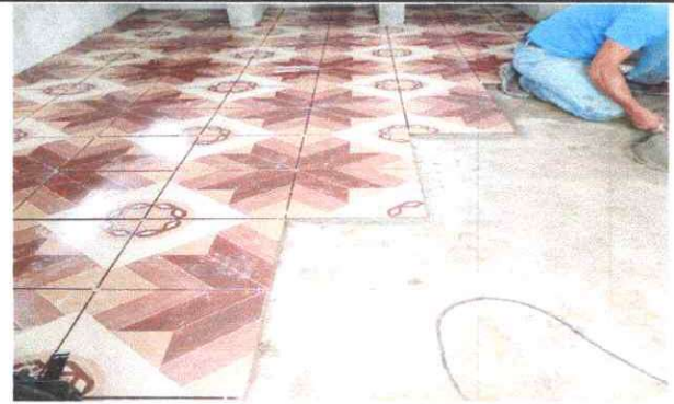
Foto 4: Reparación de torta de concreto por piso cerámico en cocina del establecimiento
