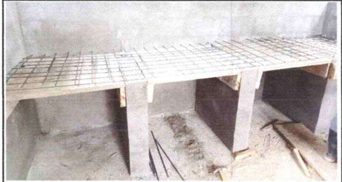
Foto 2: Sustitución y Reparación de estufa rural con chimenea en cocina del establecimiento
