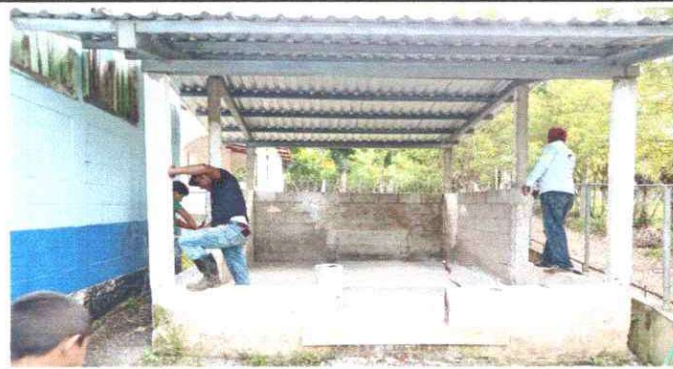
Foto 3: Reparación de muro de cocina del establecimiento
