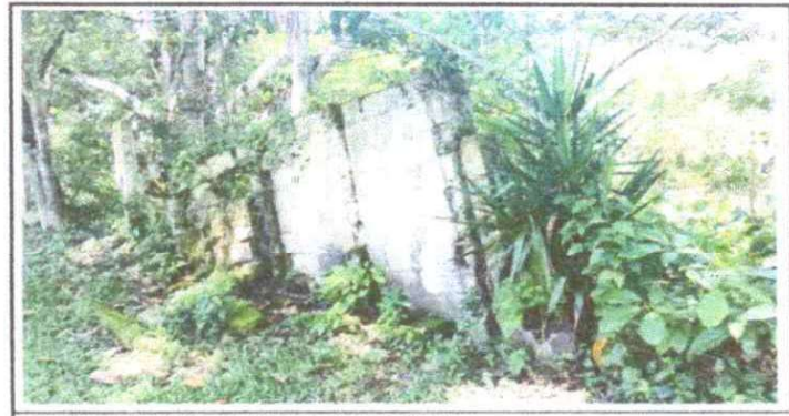
MANTENIMIENTO DE MURO PERIMETRAL
