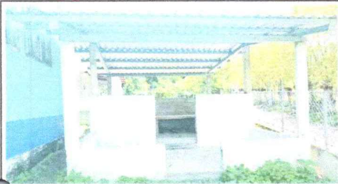
MANTENIMIENTO DE COCINA
