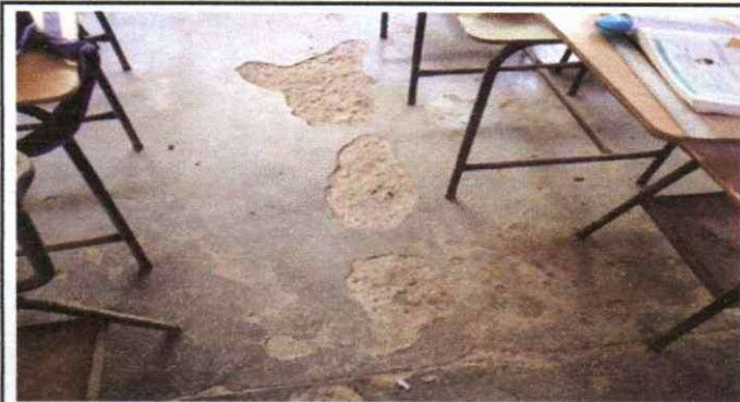
Foto 3: Sustitución de piso de torta de concreto
