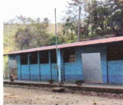
Foto 2: Sustitución de puertas
