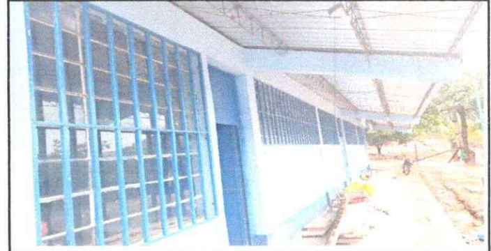
Foto 6: SUSTITUCION DE VIDRIOS
