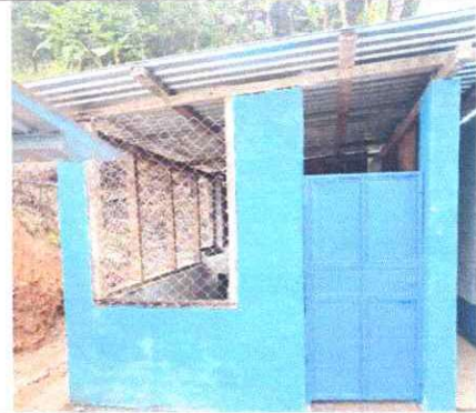
Foto 2: REPARACIÓN DE COCINA
