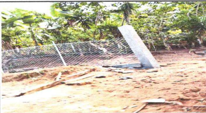
Foto 3: REPARACION DE MURO PERIMETRAL
