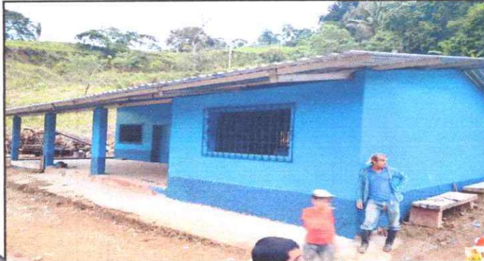
Foto 1: ESTRUCTURA DE TECHO Y REPARACIÓN DE COLUMNA
