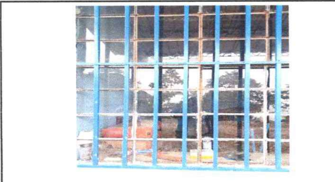
Foto 4: MANTENIMIENTO A ESTRUCTURA DE METAL DE VENTANA
