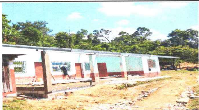
Foto1: ESTRUCTURA DE TECHO Y REPARACION DE COLUMNA
