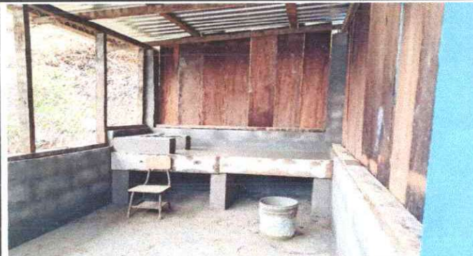
Foto 2: REPARACION DE COCINA
