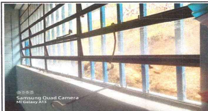
Foto 6: SUSTITUCIÓN DE VIDRIOS DE VENTANA
