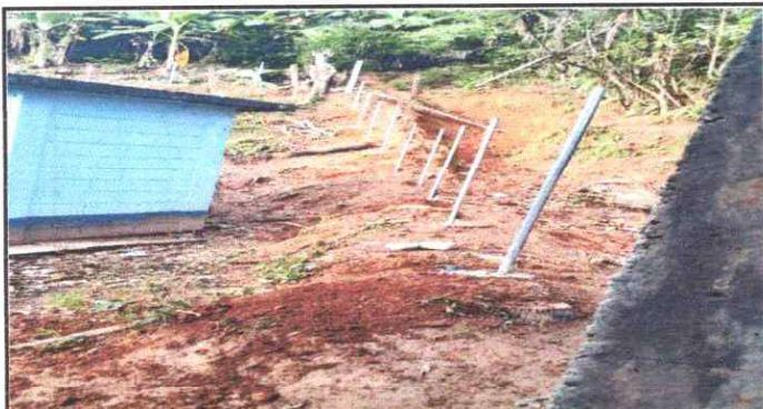
Foto 3: REPARACION DE MURO PERIMETRAL
