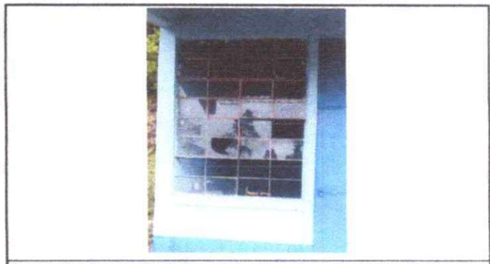
Foto 6: Sustitución de Vidrios
