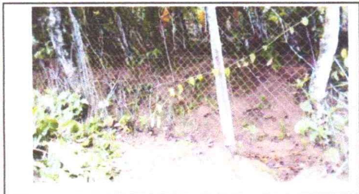
Foto 3: Reparación de Mura perimetral
