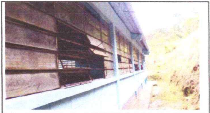
Foto 4: Mantenimiento a estructura de metal de ventana
