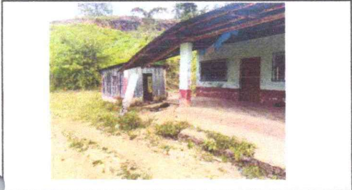
Foto 1: Estructura de Techo y reparación de columna
