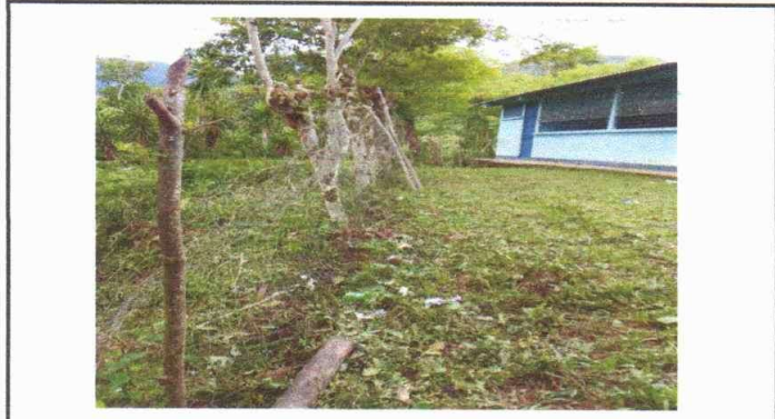
Foto 1: Mantenimiento de Muro Perimetral
