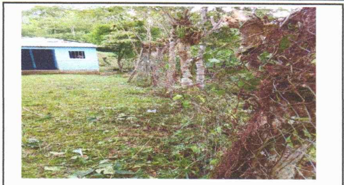
Foto 2: Mantenimiento de Muro Perimetral
