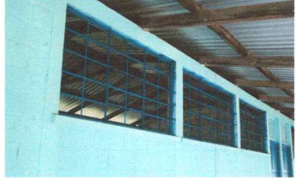
Foto 2: Mantenimiento a estructura de metal de ventana
