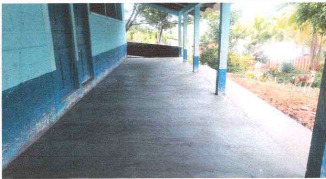
Foto 3: Sustrucción de piso de torta de concreto
