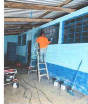
Foto 2: Mantenimiento a estructura de metal de ventana
