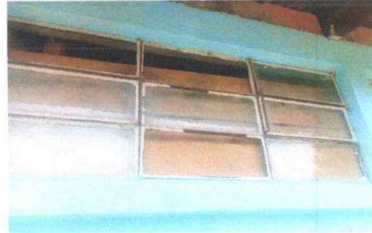
Foto 2: Mantenimiento a estructura de metal de ventana
