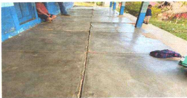
Foto 3: Sustitución de piso de torta de concreto
