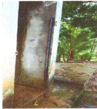
Foto 3: SUSTITUCIÓN DE PUERTAS DE SERVICIO SANITARIO
