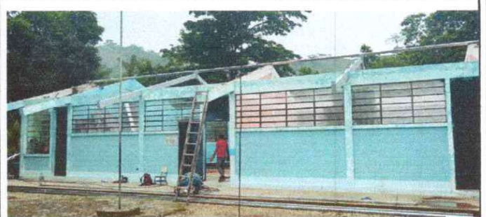
Foto 2: SUSTITUCIÓN DE ESTRUCTURA METALICA
