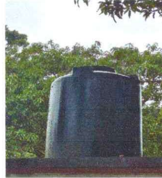
Foto 4: SUSTITUCION DE ACCESORIOS DE DEPOSITO DE AGUA
