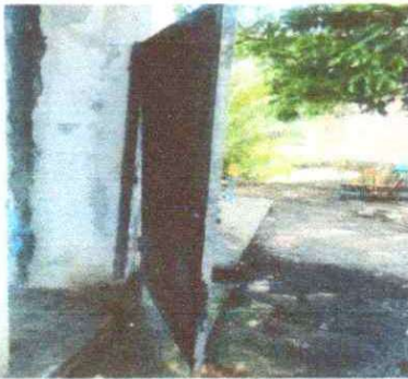
Foto 3: SUSTICIÓN DE PUERTAS DE SERVICIO SANITARIO
