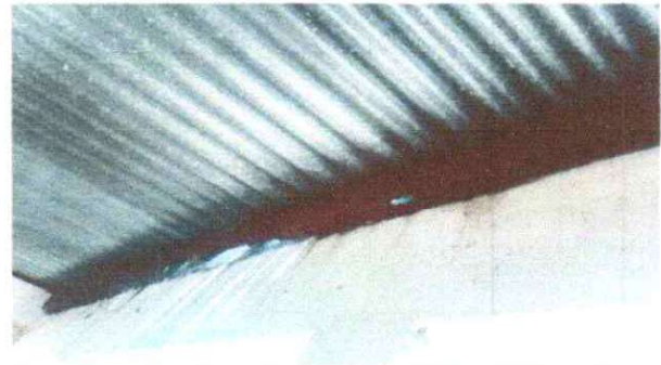
Foto 2: SUSTITUCIÓN DE ESTRUCTURA METALICA
