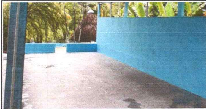
Foto 1: se finalizó la reparación de piso liso en area de salón de educación física y actividades múltiples.
