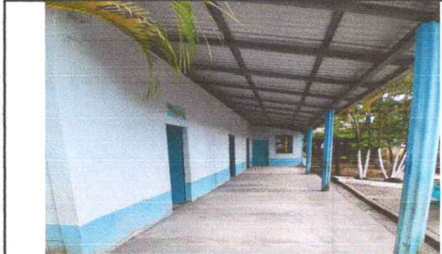
Foto 2: se finalizaron los trabajos de reparación de piso de concreto en el area de corredor de aulas.
