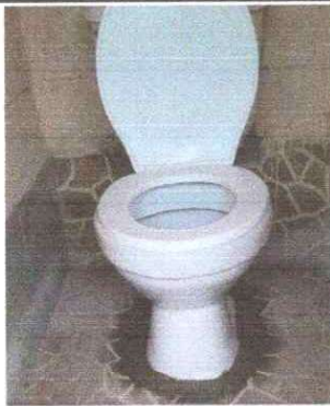
Foto 3: se completó la sustitución de inodoro
