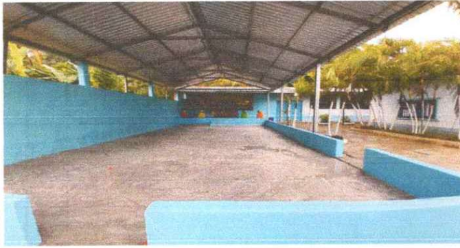
Foto1: Se sustituyó la lámina, por lámina troquelada aluzinc 12 calibre 26
