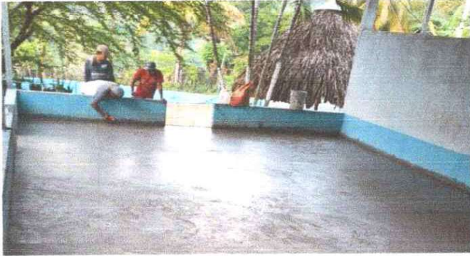
Foto 1: se inician trabajos de reparación de piso liso en area de salón de educación física y actividades multiples.
