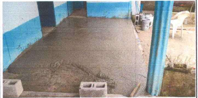
Foto 2: se iniciaron trabajos de reparación de piso de concreto en el area de corredor de aulas.
