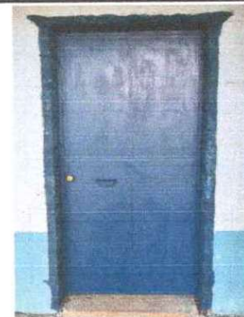
Foto 6: Sustitución de puerta
