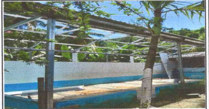
Foto 2: Se iniciaron los trabajos de Sustitución de estructura de soporte de madera, por metal
