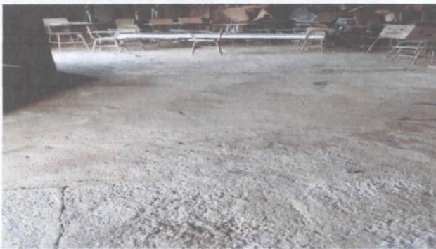
sustitucion de piso de torta de cemento
