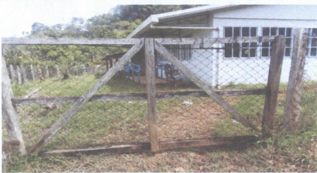
sustitucion de porton de metal
