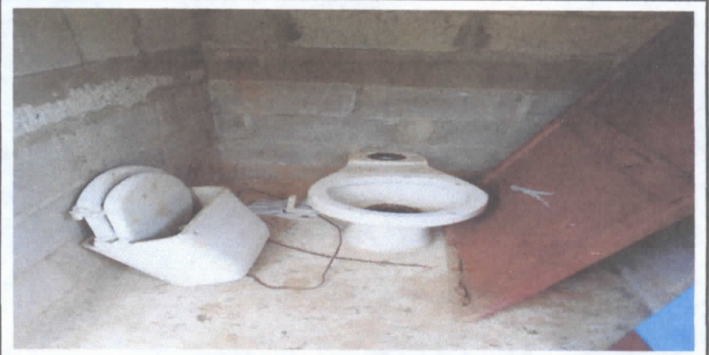
sustitucion de inodoro
