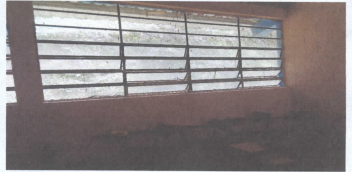
sustitucion de balcones
