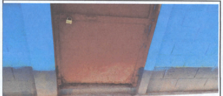
sustitucion de puertas
