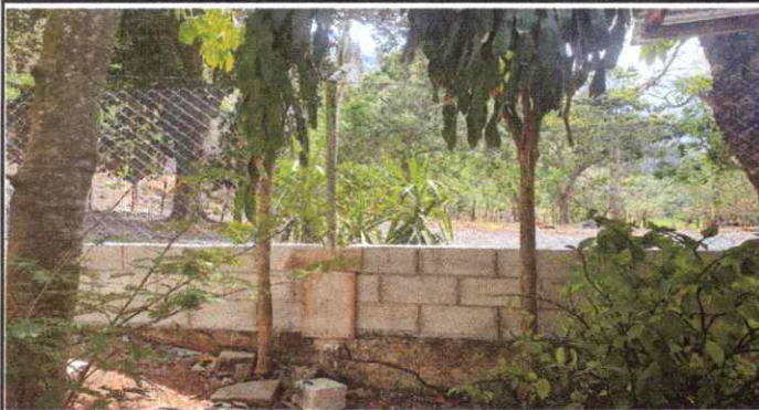
Foto 3: Remozamiento de muro perimetral. Parte izquierda. ✓
