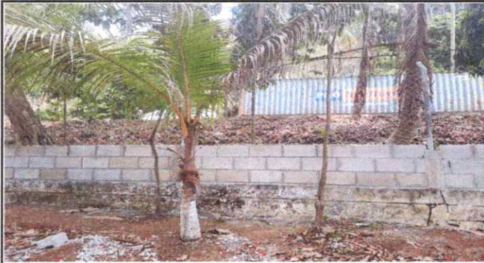
Foto 1: Remozamiento muro perimetral. Parte de enfrente. ✓
