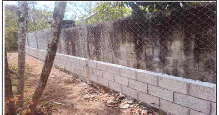
Foto 4: Remozamiento de muro perimetral. Parte de atrás. ✓
