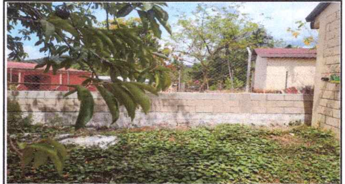
Foto 2: Remozamiento muro perimetral. Parte derecha. ✓
