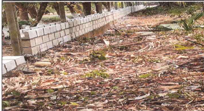
Foto 1: Remozamiento muro perimetral. Parte de enfrente.
