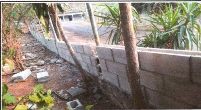
Foto 3: Remozamiento de muro perimetral. Parte izquierda.
