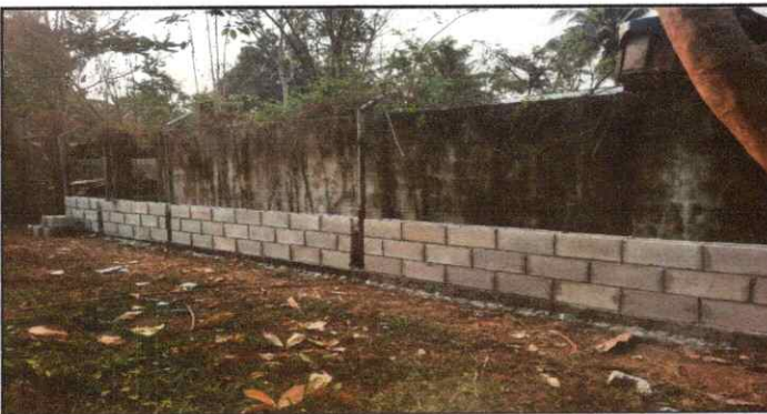
Foto 5: Remozamiento de muro perimetral. Parte de atrás.
