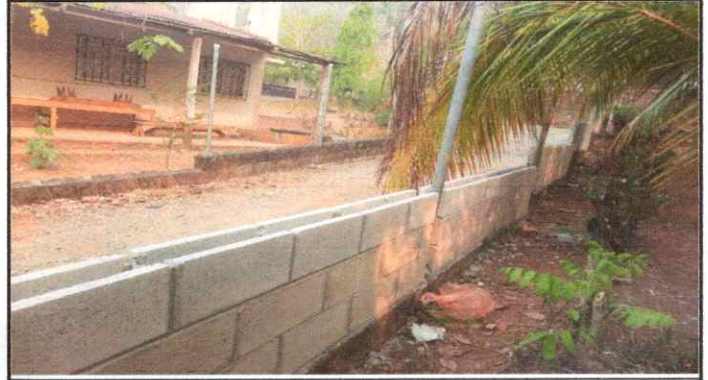
Foto 2: Remozamiento muro perimetral. Parte derecha.
