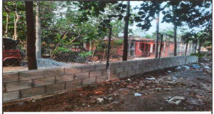
Foto 4: Remozamiento de muro perimetral. Parte de atrás.
