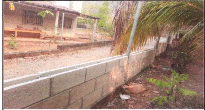
Foto 2: Remozamiento muro perimetral. Parte derecha.
