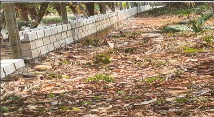
Foto 1: Remozamiento muro perimetral. Parte de enfrente.
