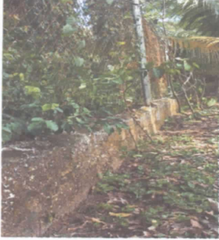
FOTO 1: Remozamiento de muro perimetral. Parte de enfrente
