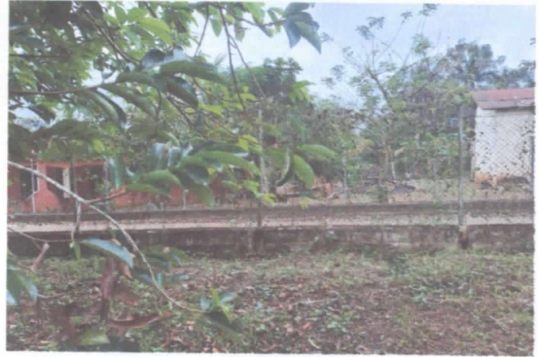
FOTO 2: Remozamiento de muro perimetral. Parte derecha
