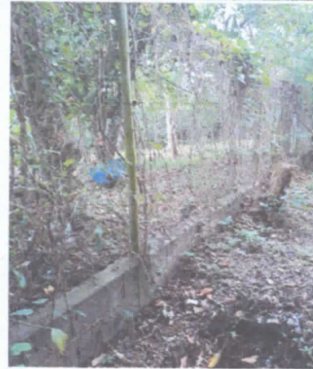
FOTO 4: Remozamiento de muro perimetral. Parte de atrás
