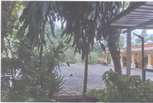
FOTO 3: Remozamiento de muro perimetral. Parte izquierda
