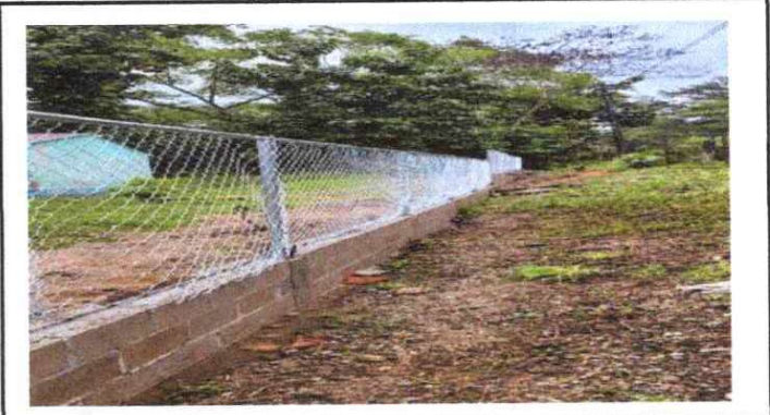
FOTO 6: MUROS PERIMETRALES, REPARACIÓN DE MURO PERIMETRAL DE BLOCK, TUBO HG Y MALLA GALVANIZADA + SOLERAS
