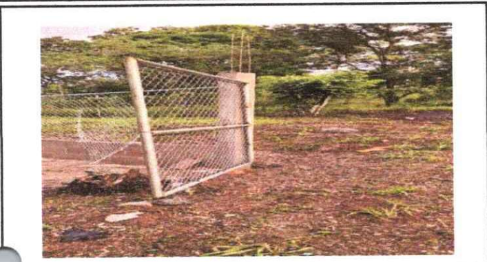
FOTO 5: MANTENIMIENTO A PORTONES, MANTENIMIENTO A PORTONES DE METAL
