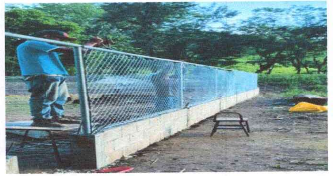
FOTO 4: MUROS PERIMETRALES, REPARACIÓN DE MURO PERIMETRAL DE BLOCK, TUBO HG Y MALLA GALVANIZADA + SOLERAS
