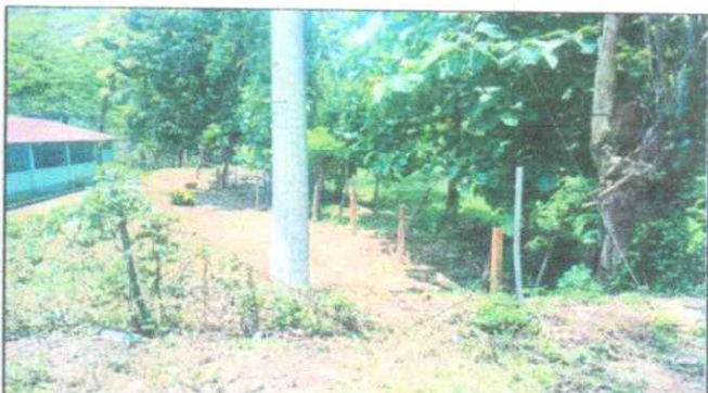
Foto 4: Mantenimiento a muro perimetral.
