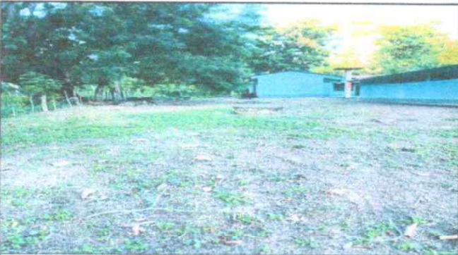
Foto 3: Mantenimiento a muro perimetral.
