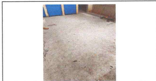
Foto 6: Sustitución de piso de torta de concreto
