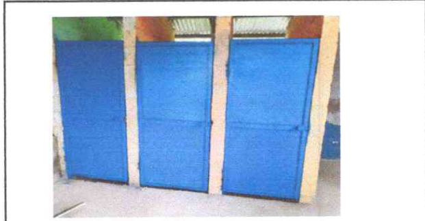
Foto 4: Mantenimiento a estructura (lijado, cambio de tubo , cepillado, sujeciones, aplicación de pintura) a puertas de servicio sanitario
