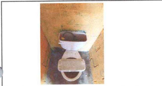
Foto7: Sustrucción de accesorios inodoro
