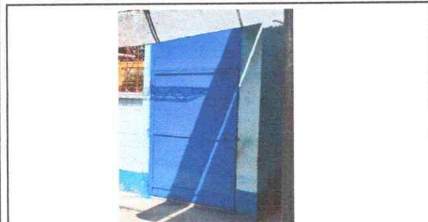
Foto 3: Sustitución de puerta
