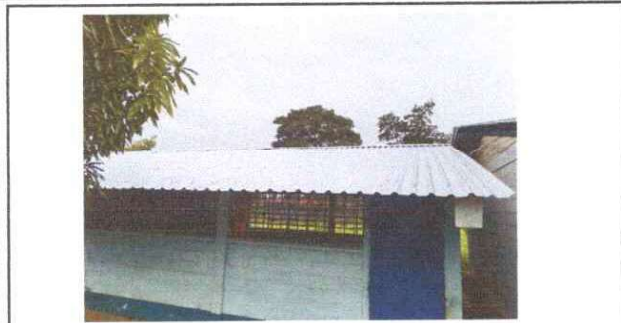
Foto1: Susustitución de lámina, por lamina troquelada aluzinc calibre 26
