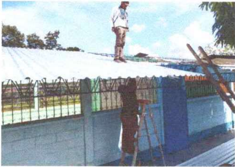
Foto1: Susstitución de lámina, por lamina troquelada aluzinc calibre 26
