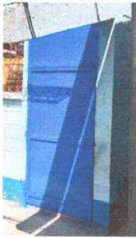
Foto 3: Sustitución de puerta
