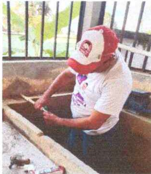
Foto 9: Sustitución de llave de chorro
