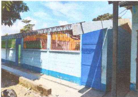
Foto 5: Mantenimiento a estructura de metal de ventana
