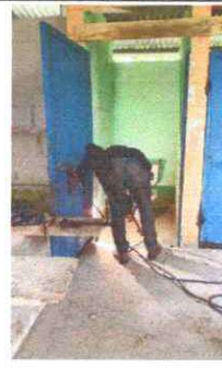
Foto 4: Mantenimiento a estructura (lijado, cambio de tubo , cepillado, sujeciones, aplicación de pintura) a puertas de servicio sanitario
