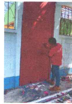
Foto 2: Mantenimiento a estructura (lijado, cambio de tubo , cepillado, sujeciones, aplicación de pintura) de aulas
