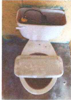
Foto7: Sustitución de accesorios inodoro
