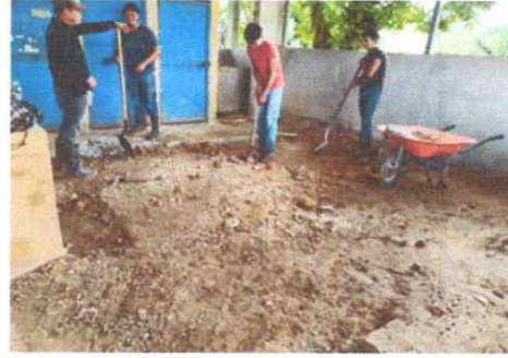
Foto 6: Sustitución de piso de torta de concreto
