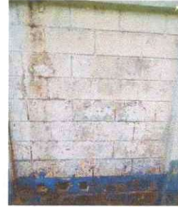
Foto 8: Sellado de grietas y fisuras en muros
