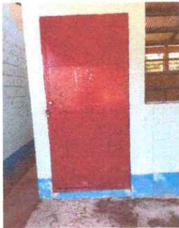
Foto 3: Sustitución de puerta
