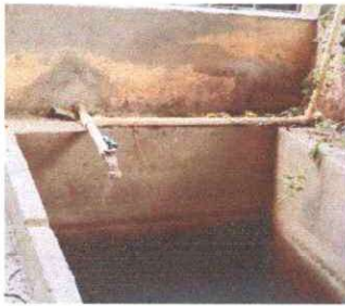
Foto 9: Sustitución de llave de chorro
