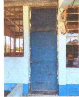
Foto 2: Mantenimiento a estructura (lijado, cambio de tubo , cepillado, sujeciones, aplicación de pintura)
