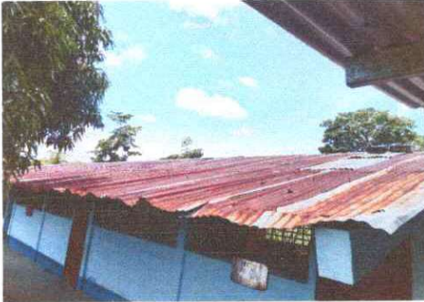
Foto 1: Susustitución de lámina, por lamina troquelada aluzinc calibre 26
