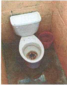
Foto7: Sustitución de accesorios inodoro
