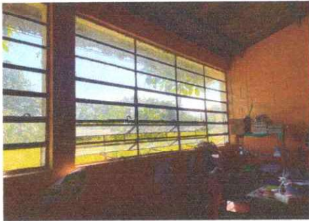
Foto 5: Mantenimiento a estructura de metal de ventana
