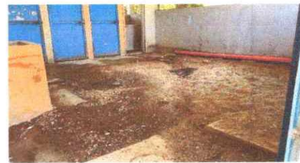
Foto 6: Sustitución de piso de torta de concreto
